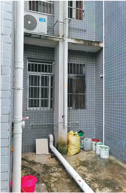
小图:物业公司小区在23栋一楼外接出管道临时解决排污管道堵塞倒灌问题。 本报记者 易宗平 摄 大图:小区租户家中被生活污水倒灌的情景。 受访者供图
