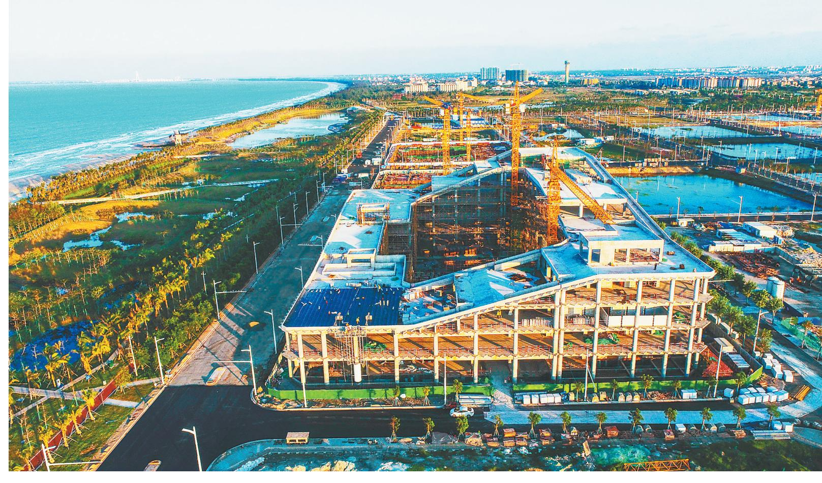
日前，俯瞰主体工程已经完工的海口江东新区中国大唐国际贸易中心项目。该项目正在加快推进进行二次结构施工，消防、空调、通风等预安装设施今年12月底完成。
