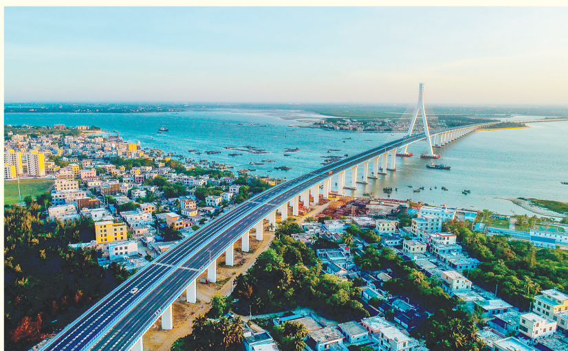
海文大桥。海南日报记者 张茂 摄
