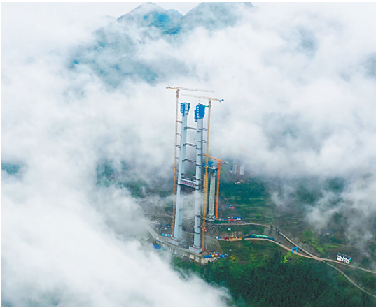
11月21日拍摄的桐梓河特大桥主塔。当日,随着最后一方混凝土浇筑完成,由中铁广州局承建的贵州金(金沙)仁(仁怀)桐(桐梓)高速桐梓河特大桥主塔成功封顶。据了解,该桥全长1422米,主跨达965米,主塔高208米,是全线重要的控制性工程。 新华社记者 刘续 摄
