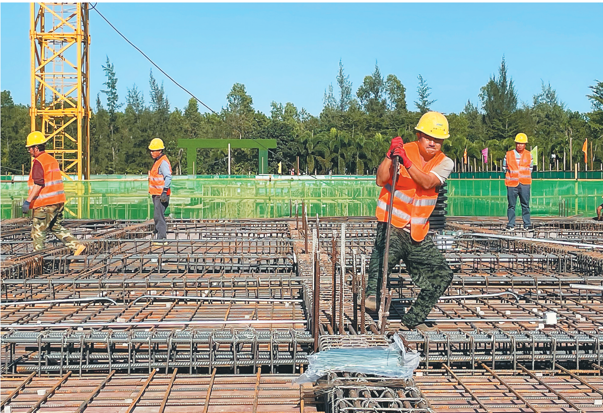
12月3日,在海口空港地埋式水质净化中心(一期)项目工地,工人正在将钢筋折弯。 本报记者 习霁鸿 摄
