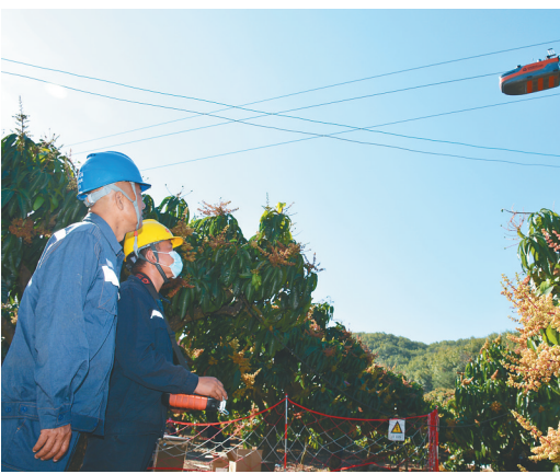
南方电网海南三亚供电局工作人员利用绝缘涂覆机器人实施作业。 刘昌 摄
