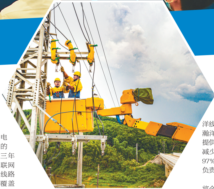
南方电网海南电网公司开展带电作业,提高供电可靠性。 吴清炳 摄
