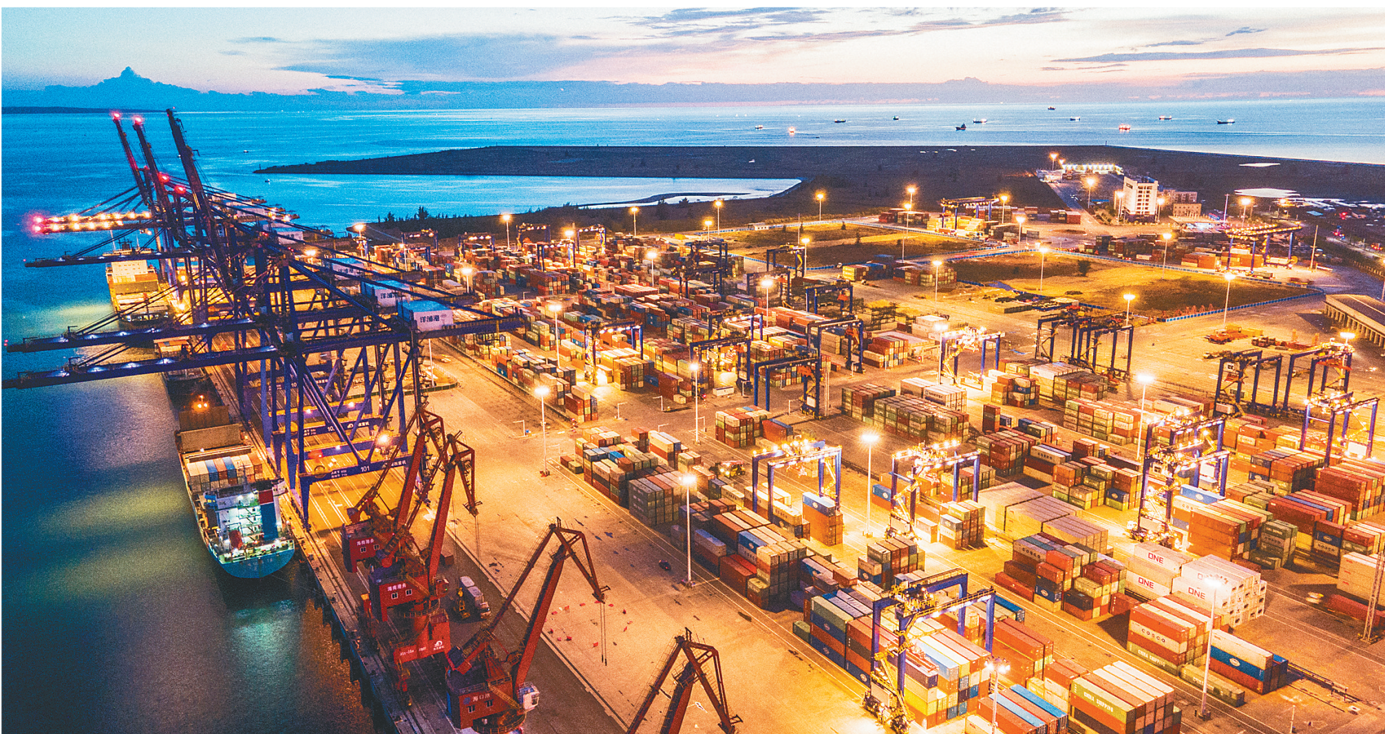
洋浦经济开发区国际集装箱码头。本报记者 陈元才摄
