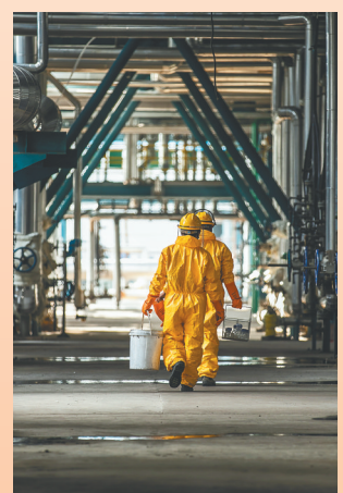
华盛pc项目建设现场。
