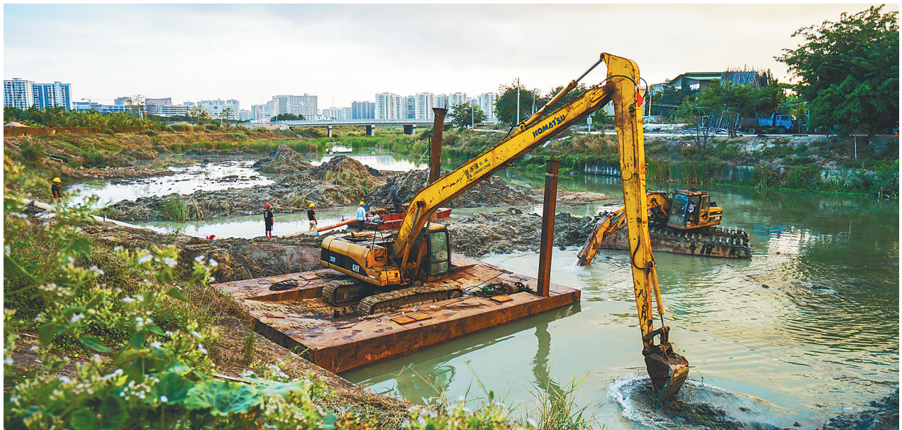
1月5日，在三亚河国家湿地公园，工程人员操作水陆两用挖掘机进行河道清淤、清障作业。本报记者 武威 摄
