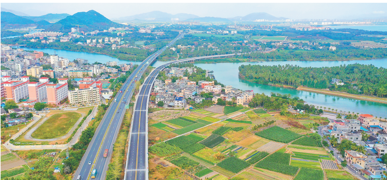
环岛旅游公路土福湾至海棠湾通道工程完工
