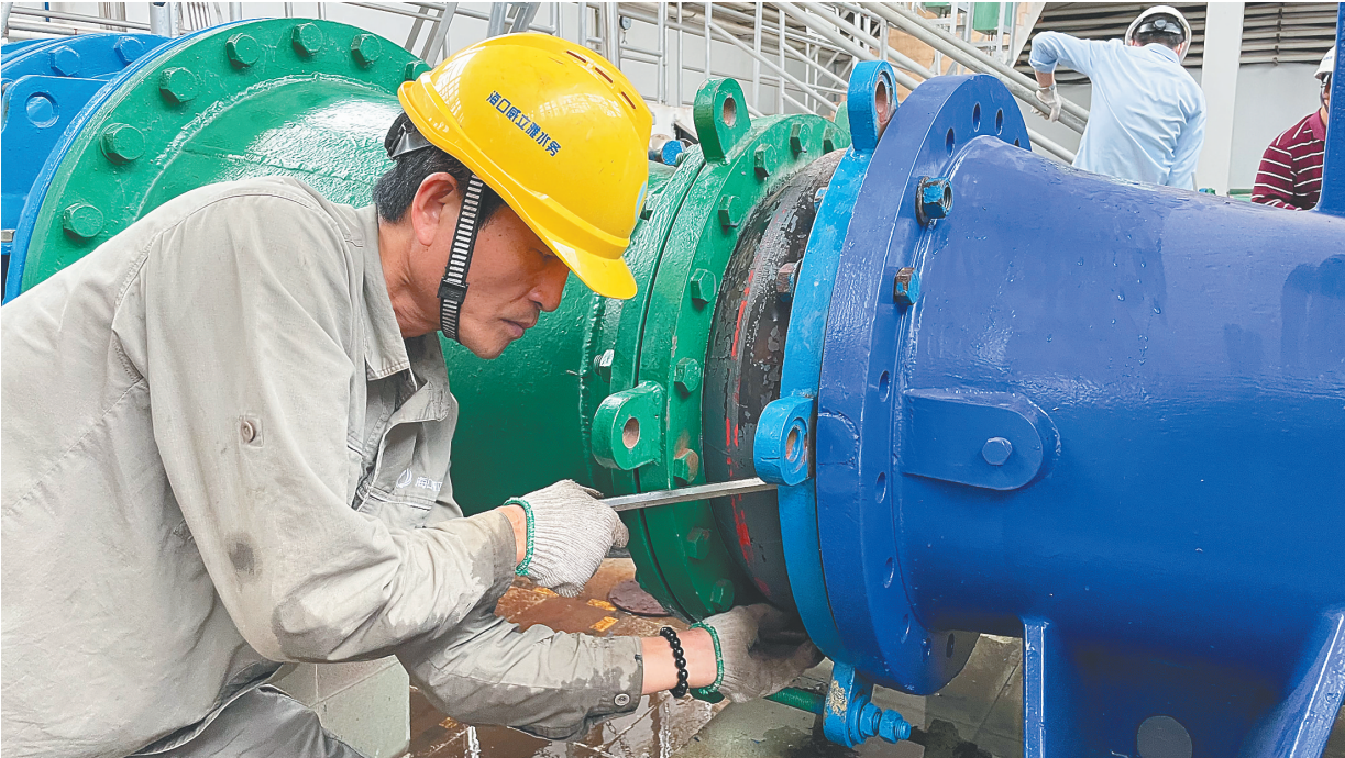
米铺维修队队员在为水泵更换泵头。本报记者 习霁鸿 摄
