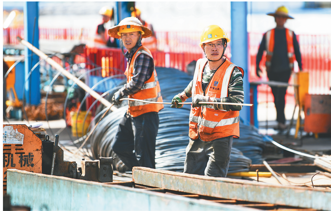
日前,在海口江东新区东寨新居二期项目施工现场,工人正在进行施工作业。 本报记者 袁琛 摄
