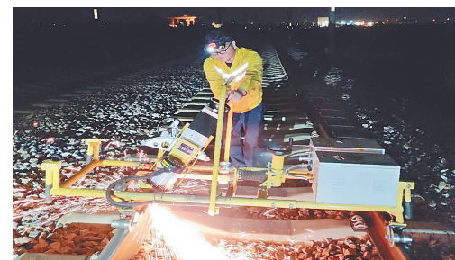
贾云斌在进行钢轨打磨作业。 通讯员 王世江 摄
