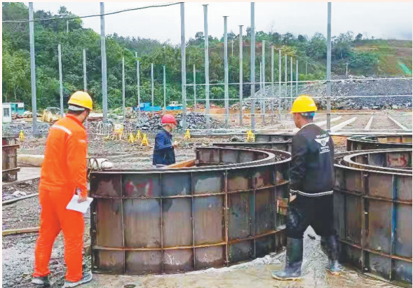
2月7日，迈湾水利枢纽工程施工现场，工人们在廊道预制顶拱进行验收。 通讯员 王建平 摄
