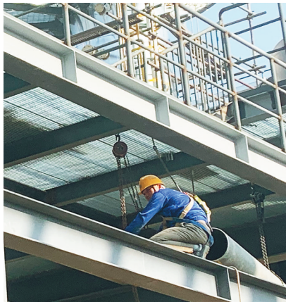
2月7日，海南精细化工二期工程丙烯腈系列装置项目施工现场，工人正在安装工艺管道。 本报记者 张文君 摄
