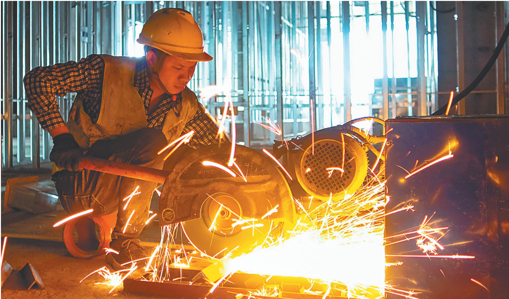
2月13日，在海南省中医院新院区项目建设现场，工人在各楼层间加紧进行外立面以及室内装修工作。图为工人在进行消防管安装加工作。据介绍，海南省中医院新院区项目计划于今年第二季度实现全面完工，9月交付使用。项目建成后，将打造成集医疗、科研、教学、保健、康复等功能为一体的、具有中医文化特色的省级现代化综合性龙头中医医院。 文/本报记者 刘梦晓 图/本报记者 封烁
