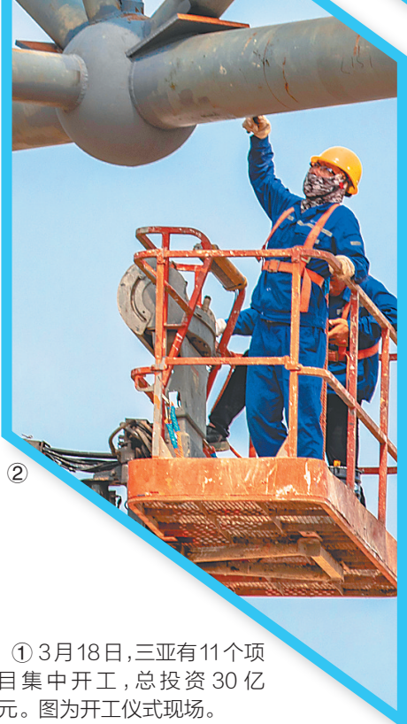
② 3月18日，在琼中体教融合产业发展（琼中女足）示范区项目建设现场，工人涂刷防锈漆。
