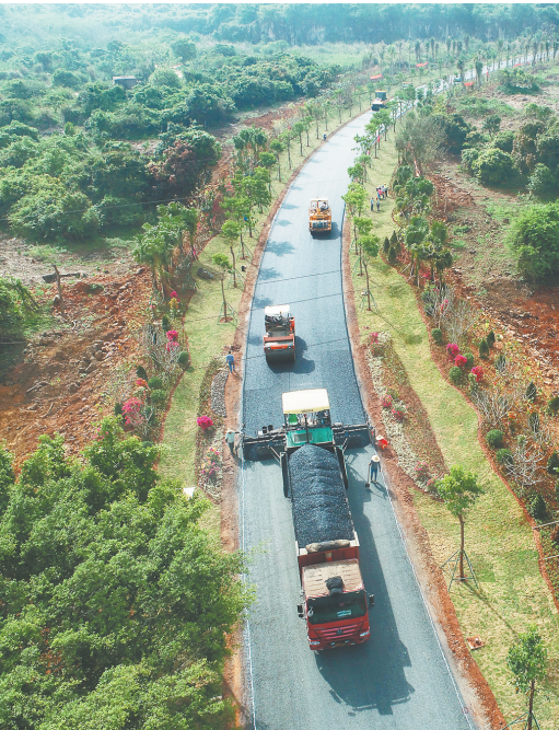
在海口火山口绿色长廊改造拓宽项目现场,工人正在铺设沥青。
