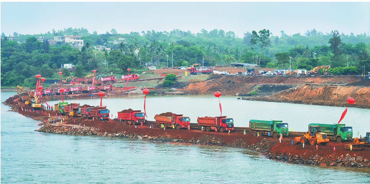
3月29日上午，海口市南渡江龙塘大坝枢纽改造工程成功实现一期围堰合龙，标志着该工程正式进入施工阶段。 本报记者 封烁 摄
