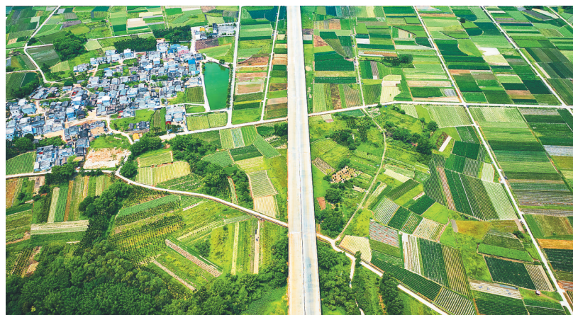
建设中的国道G309定安至澄迈段春芳特大桥项目。本报记者 封烁 摄
