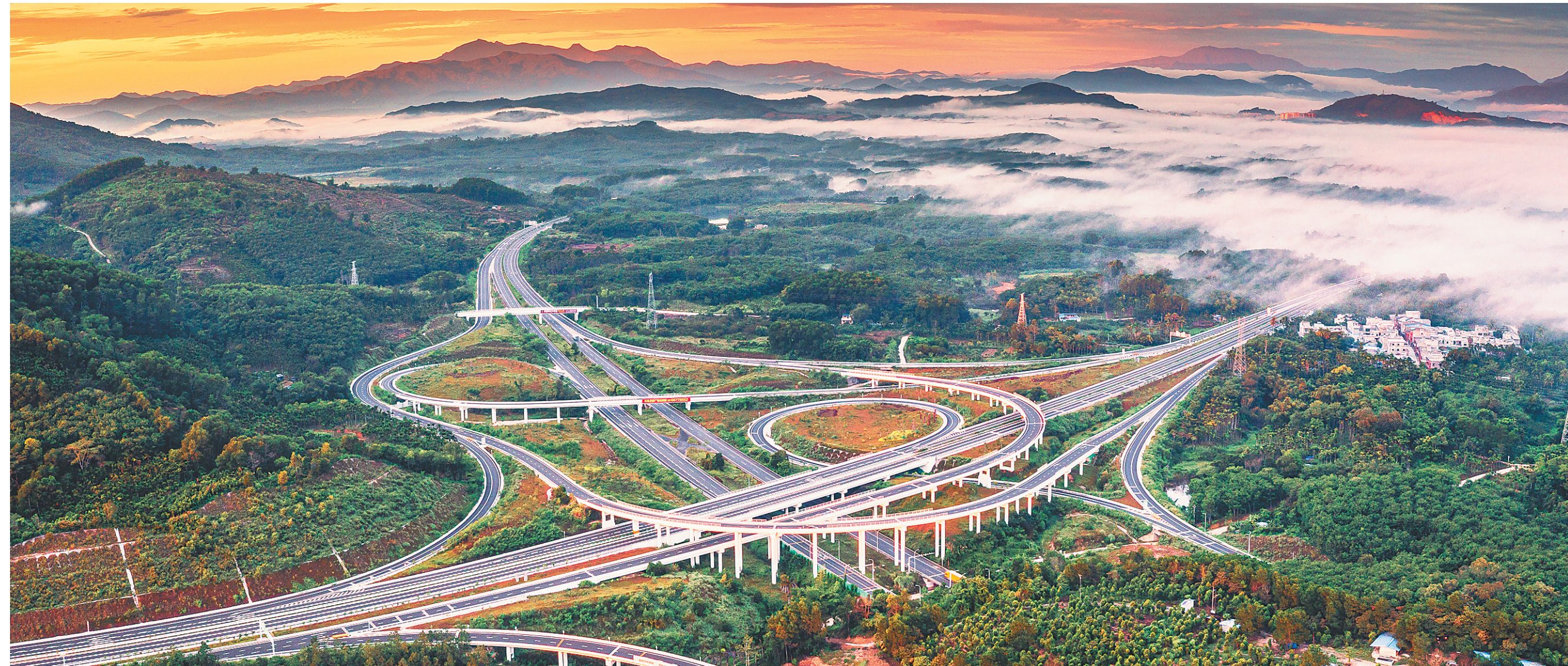
海南中线高速公路岭门互通。通讯员 哲断 摄
