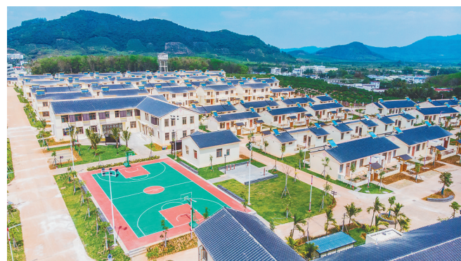
东方市东河镇苗村新居。据悉，苗村将于今年6月底前完成生态搬迁工作。通讯员 赵茜 摄
