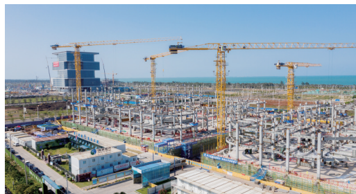
建设中的海南银行总部大楼项目。
