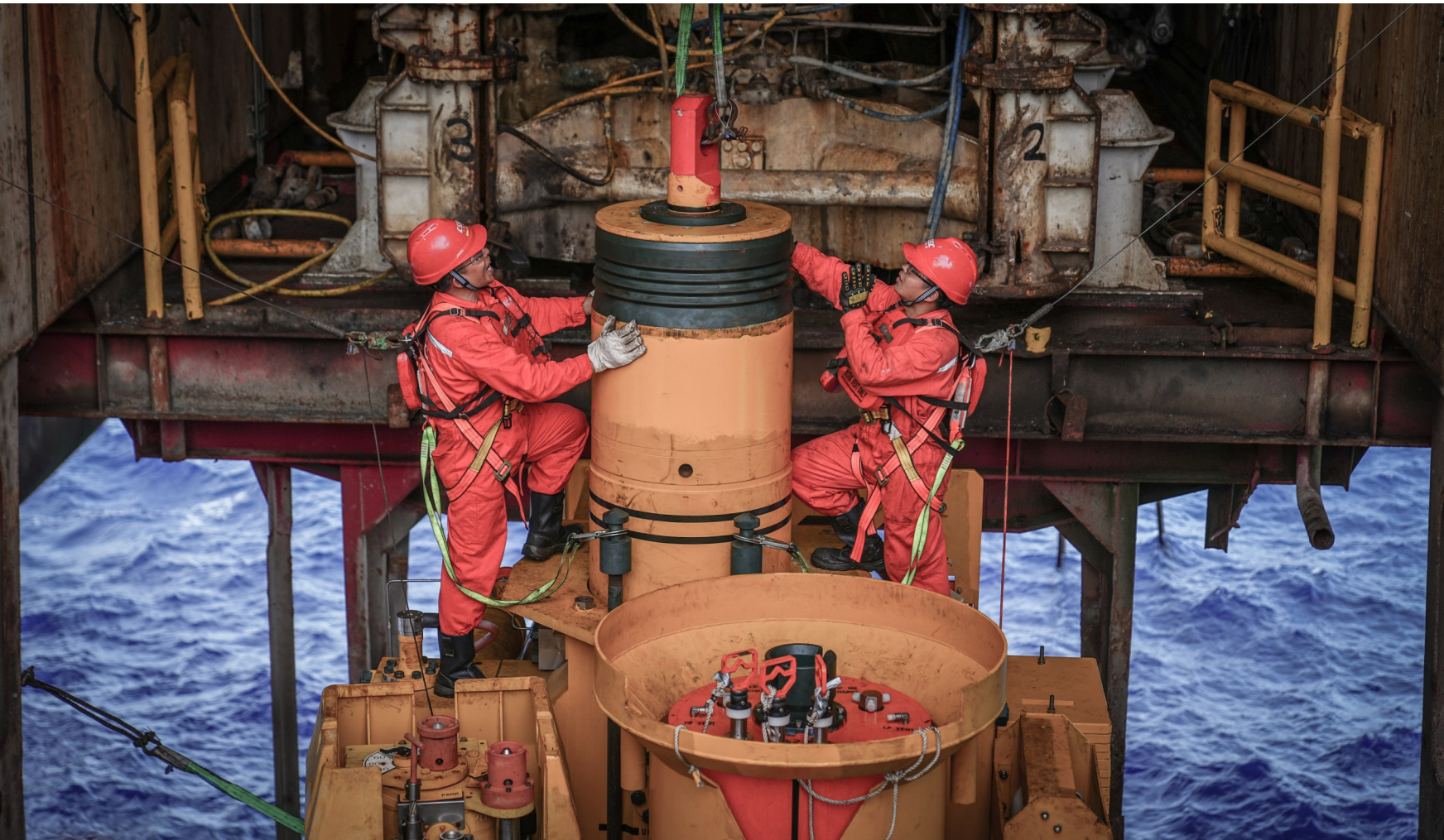
5月10日，国产采油树在月池顺利就位后，工程师们正在对其进行下水安装前最后环节的检查。本版图片均由本报记者 张茂 摄
