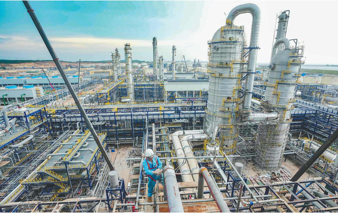
在海南炼化100万吨乙烯项目施工现场，一名工人在打磨刚焊接的管廊。
