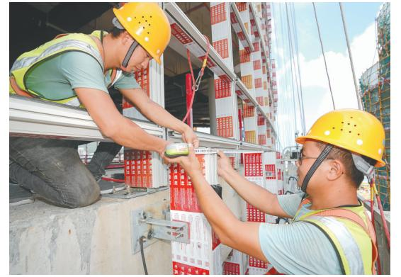
陵水黎安国际教育创新试验区图书馆(暨国际学习中心)项目工地，工人进行幕墙安装施工。
