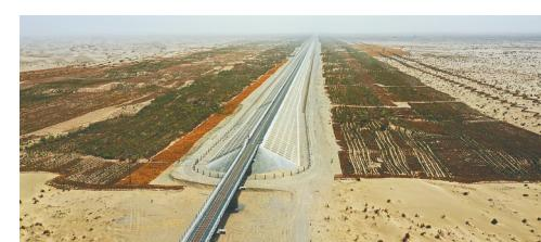
图为在和若铁路沿线拍摄的芦苇沙障、芦苇方格和耐旱植物组成的防沙“三件套”。新华社发
