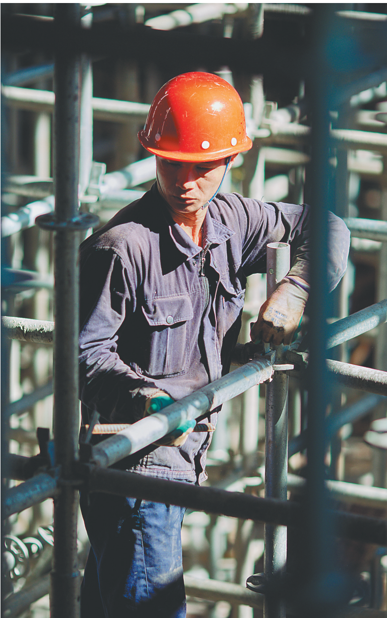
工人在拆卸脚手架。
