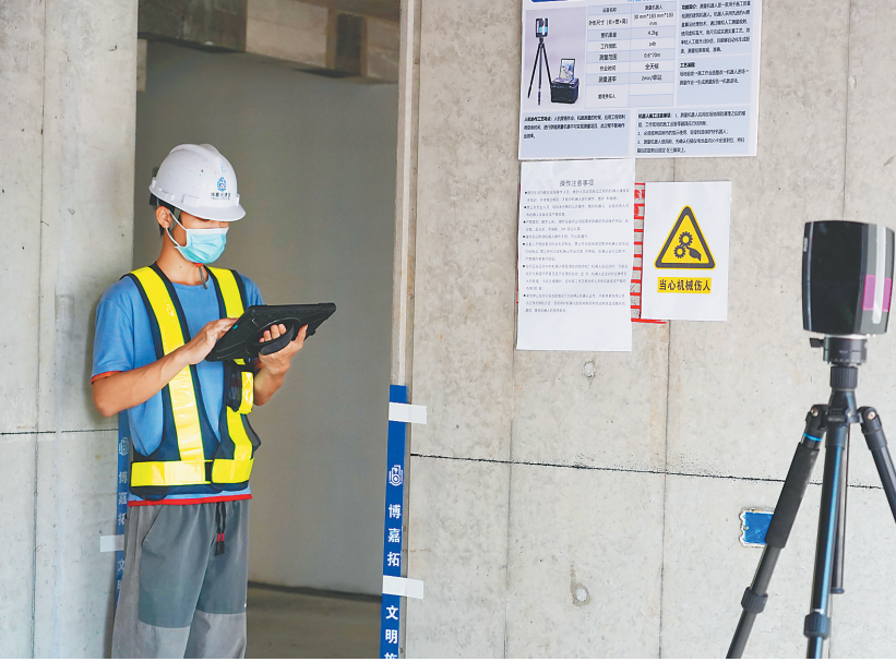
在海口碧桂园美舍仕家项目，博智林测量机器人在作业。
