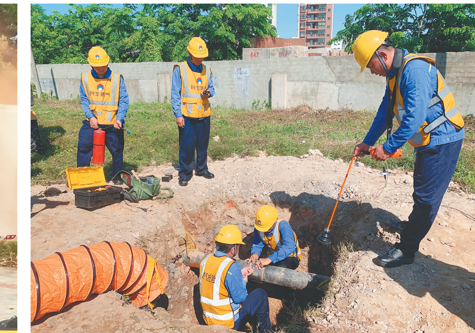
燃气110联动抢险队对泄漏点进行堵漏,修复管道。
