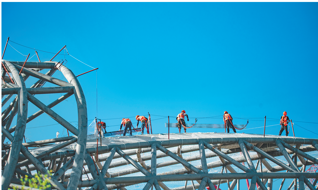
9月1日，施工人员在琼海市文化体育中心钢结构顶棚上施工。本轮疫情发生后，该项目文体板块一期施工方采取“点对点”全封闭式管理模式，严格落实各项防疫措施，赶工期、抢进度，保质保量推进施工进度。 特约记者 蒙钟德 摄
