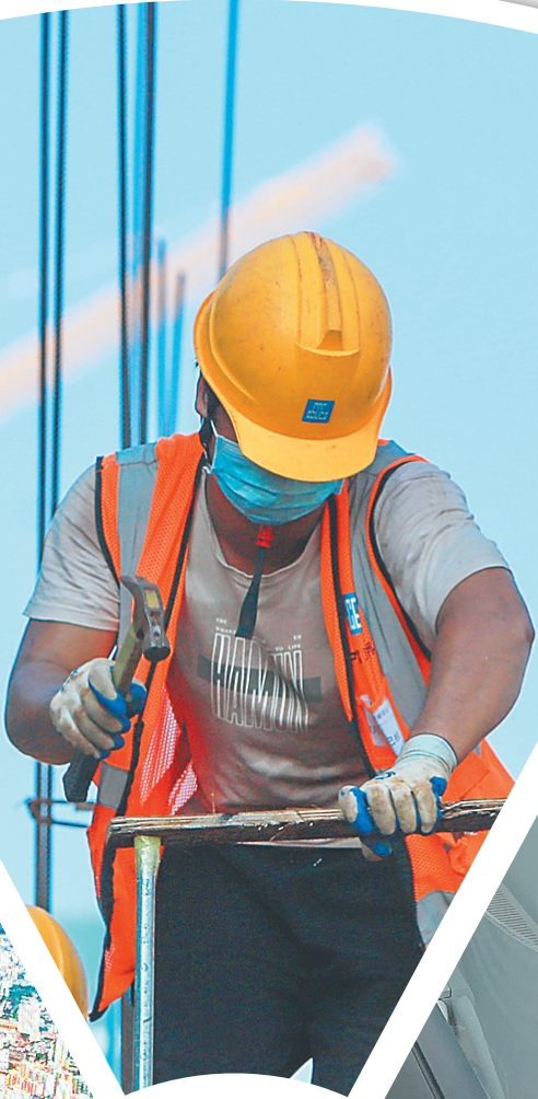
↑ 9月17日下午，位于三亚中央商务区的中粮·三亚大悦中心项目（四期）施工区域，工人们在水电管进行加固、除锈。 见习记者 王程龙 摄
