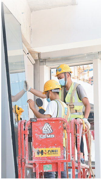
海南陵水黎安国际教育创新试验区图书馆项目现场，工人正在安装幕墙玻璃。中建五局供图
