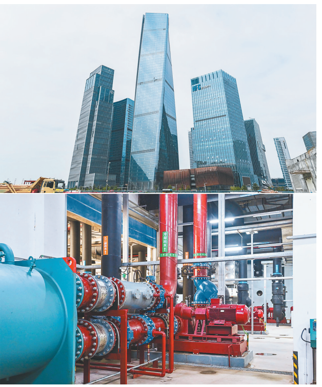
深圳前海蛇口自贸区10号冷站运行的超级空调设备(下图)，这个冷站为周边100万平方米的写字楼有效供冷(上图)(拼版照片)。新华社记者 刘大伟 摄
