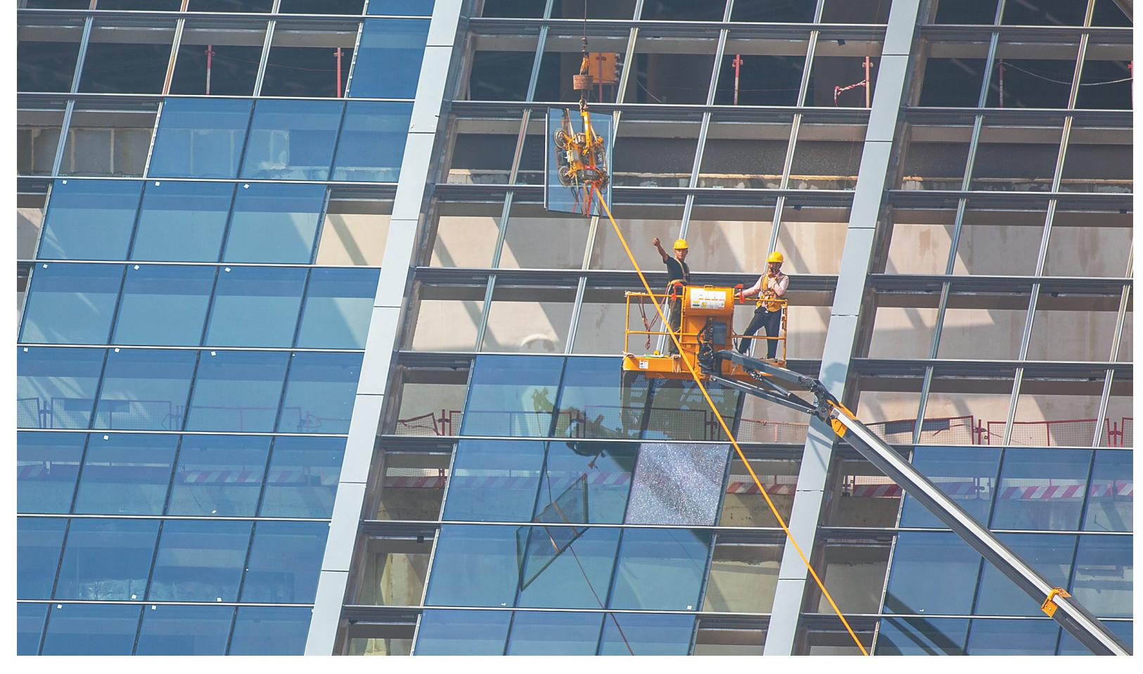
10月9日，在海口新海滚装码头客运综合枢纽站项目现场，施工人员在作业。目前该项目正在进行玻璃幕墙和金属屋面的施工，建成后将大大提升新海港区的交通集散功能，加速推动新海港成为海南陆岛运输综合交通门户。
