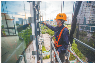
在三亚中央商务区企业孵化基地项目施工现场,工人在安装楼体幕墙。 本报记者 王程龙 摄
