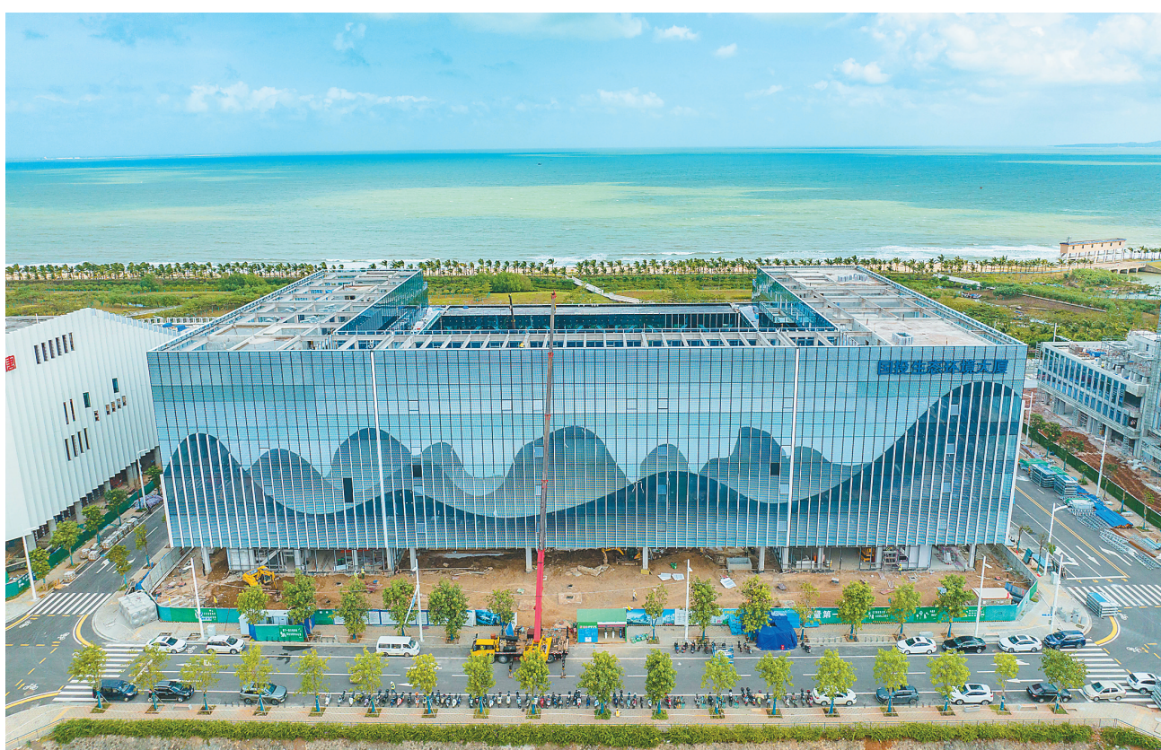
近日,在海口江东新区总部经济区,建设中的国投生态环境大厦项目幕墙呈现出一幅“山水画”。当下,海口江东新区各在建重点项目加紧施工,江东新区聚焦重点区域、重点项目、重要节点,创新机制、强化保障、优化服务、提升管理,截至目前已累计开工项目213个、完工77个。本报记者 李天平 摄
