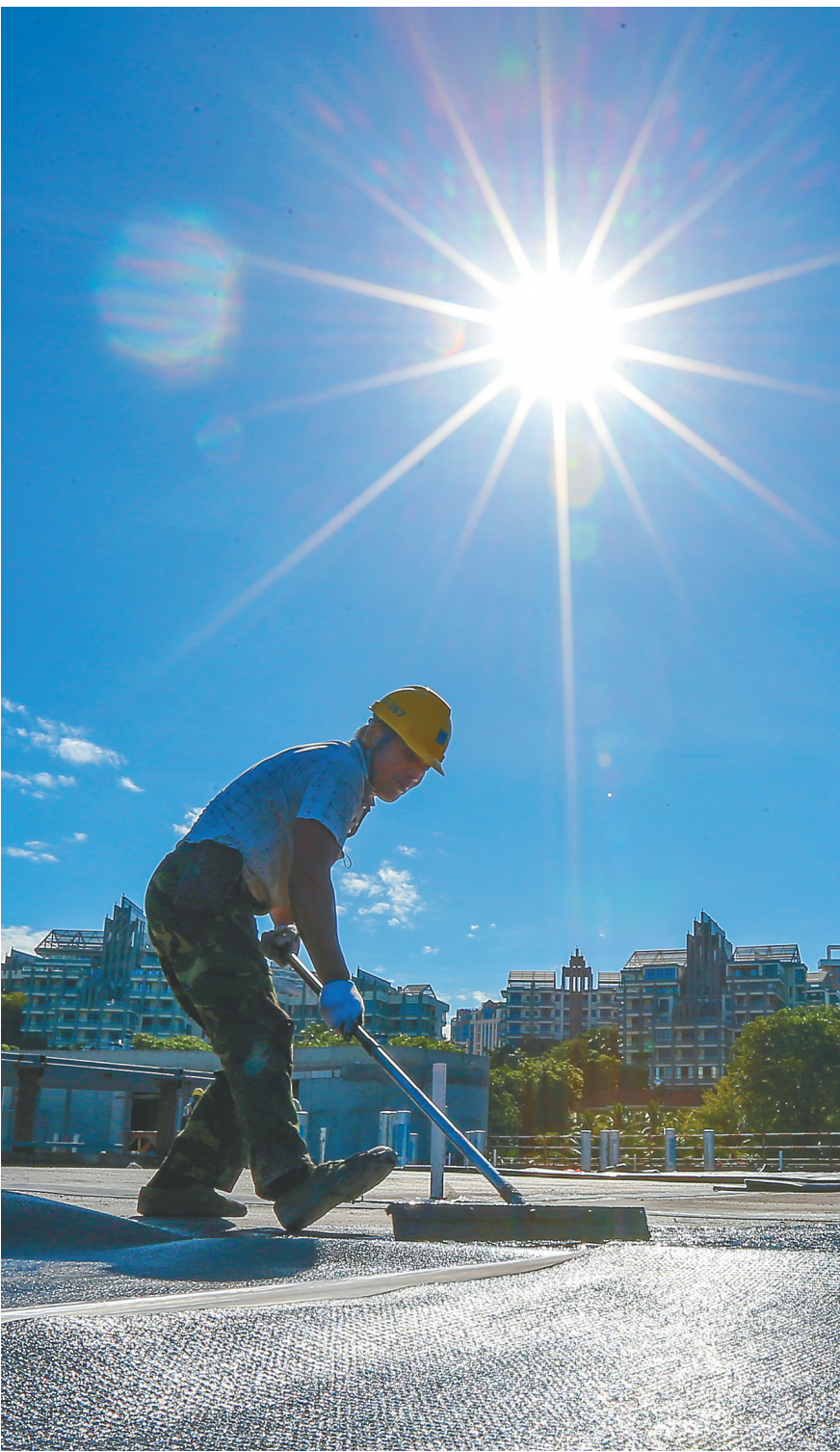
工人师傅顶着太阳在屋面铺设防水沥青。
