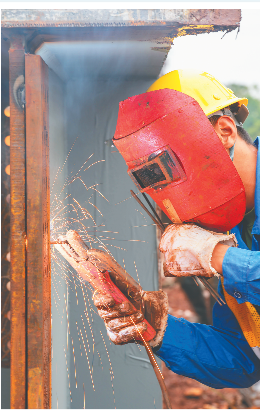
11月9日，在海口综合保税区国贸物流海口仓储项目工地，工程人员正在进行钢结构电焊施工。
