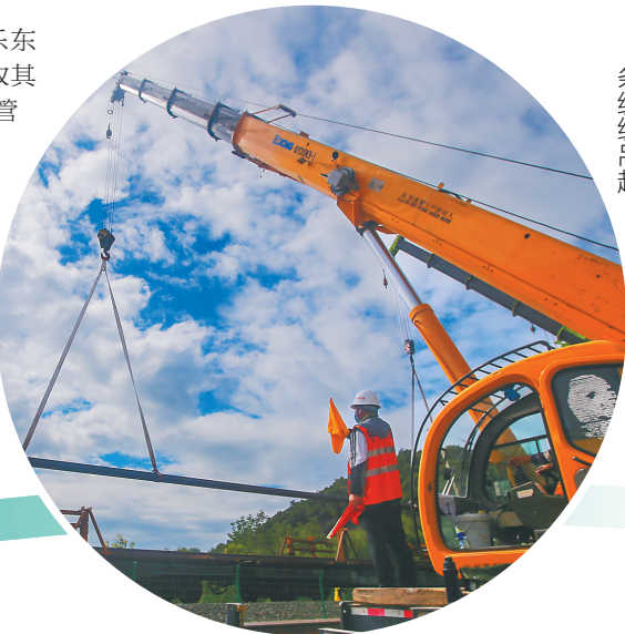
三亚至乐东公交文化旅游化铁路改造工程现场，随着施工指令，汽车吊将长达一百米的长轨缓缓吊起。
