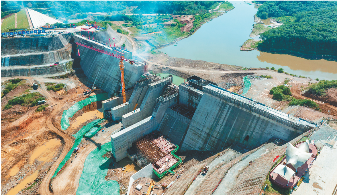
十一月二十九日,儋州北门江天角潭水利枢纽工程主坝首个坝段顺利封顶。本报记者李天平摄
