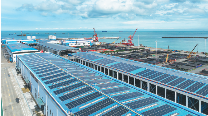
在海南中海石油码头有限公司码头,智能化仓库屋顶分布式光伏发电项目已并网发电。
