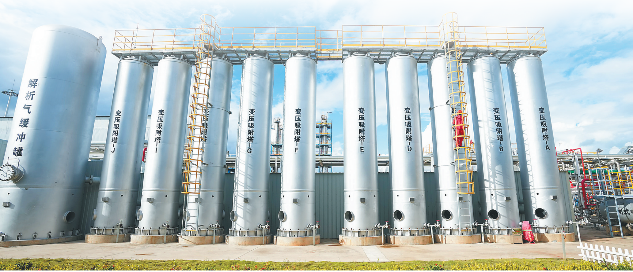
近日，中石油海南福山油田花场油气处理站的二氧化碳分离装置变压吸附塔投入使用。
