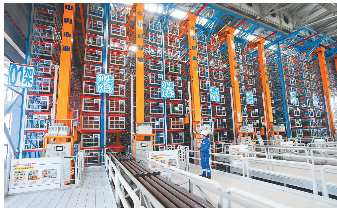
11月24日，在海南中海石油码头有限公司智能化仓库，工作人员正在进行管材出库操作。
