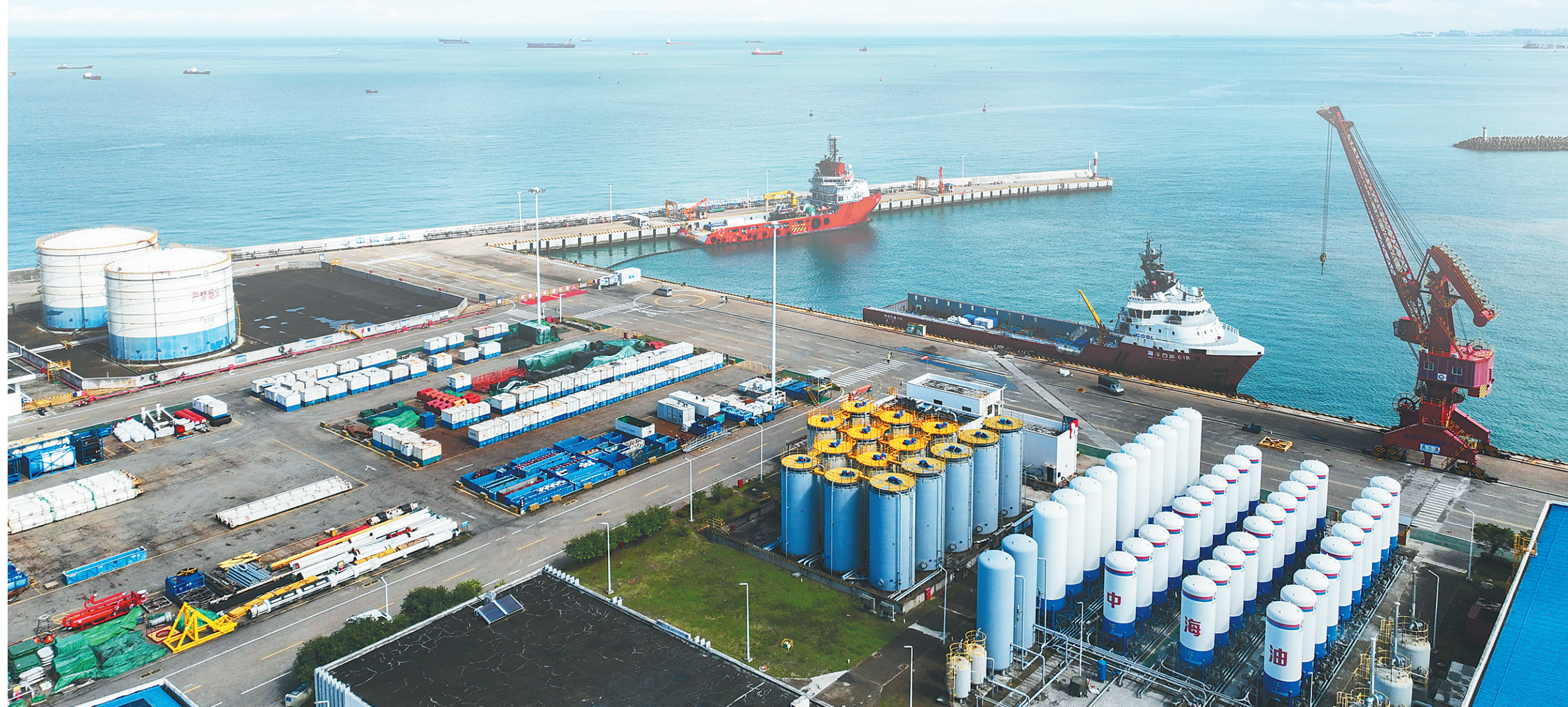
11月24日，在海南中海石油码头，作业货船正在进行补给作业。
