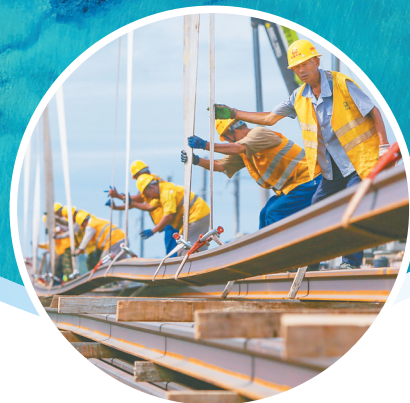
三亚至乐东公文化旅游化铁路改造工程凤凰西线路所施工点,施工人员配合机械将长达100米的长轨条吊起。 海南日报记者 王程龙 摄
