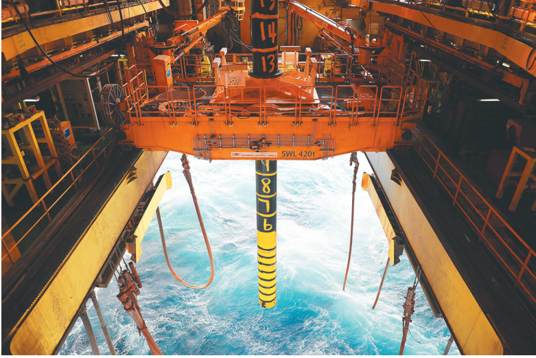
↑“深海一号”二期工程钻完井作业所用导管正在下入海中。 ←“深海一号”二期工程钻完井作业现场鸟瞰。
