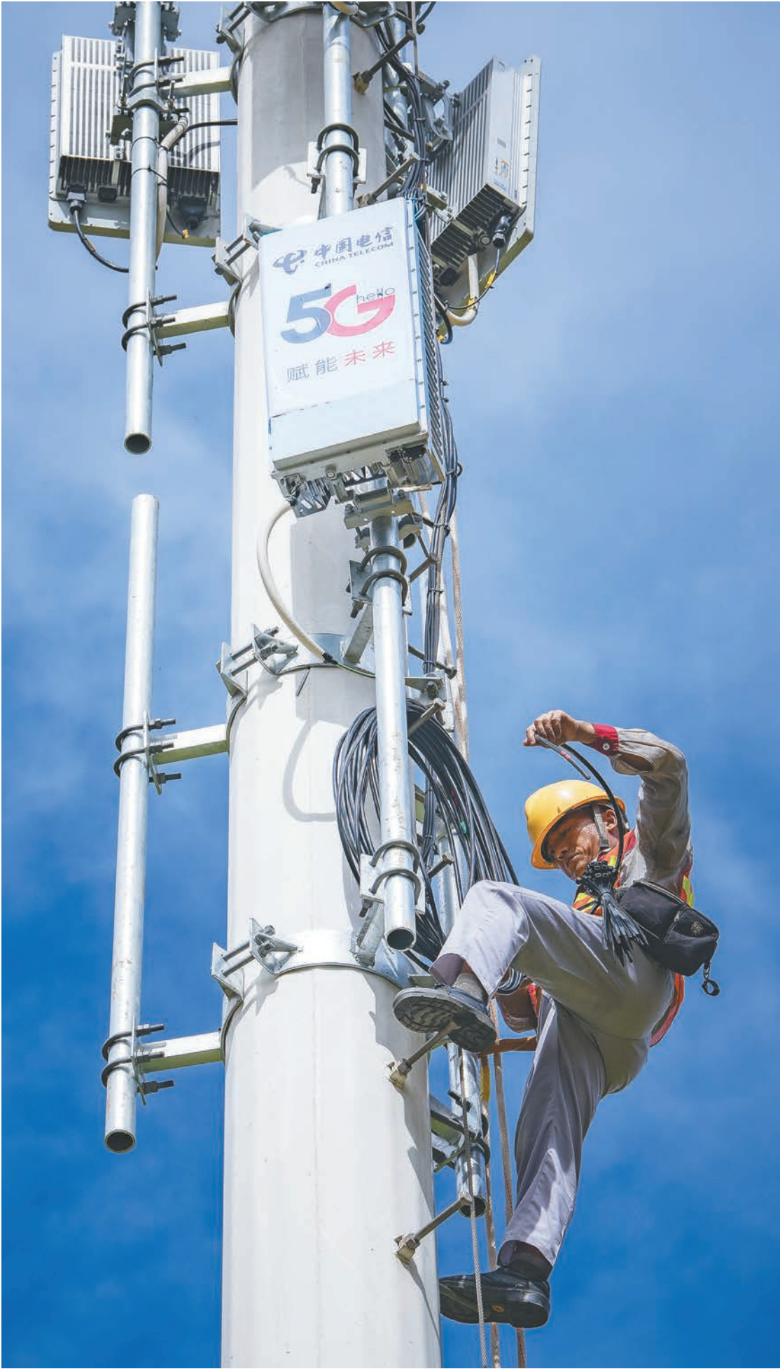
电信公司技术人员正在管塔上安装5G基站设备。
