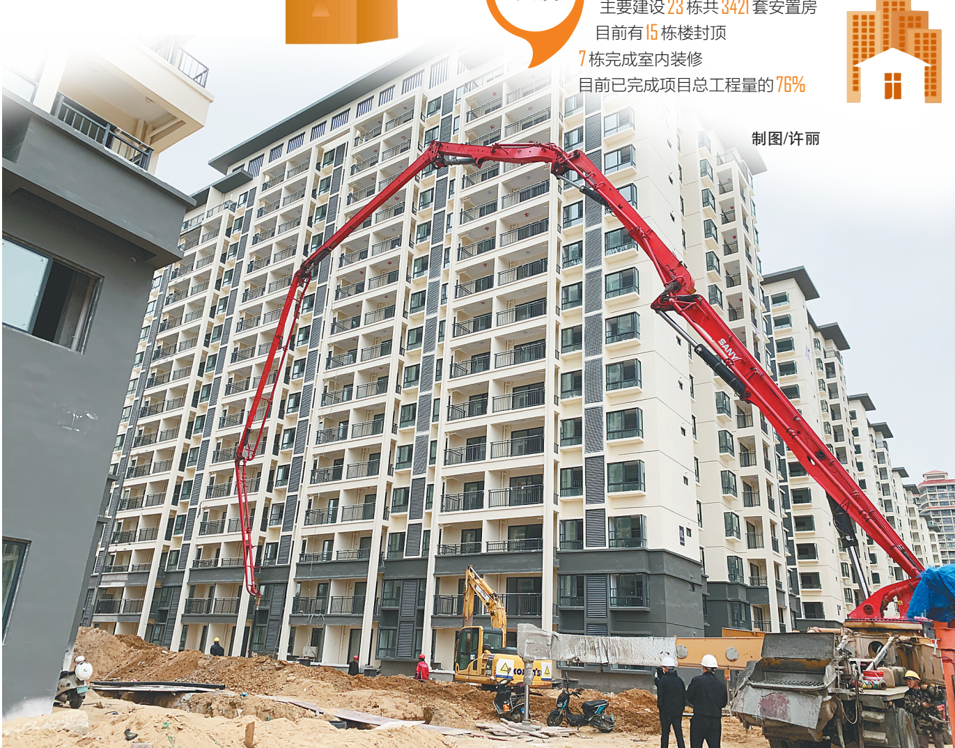
近日，在东方滨海片区(一期)棚户区改造安置房项目现场，工人对小区道路进行混凝土浇筑。 本报记者 张文君 摄
