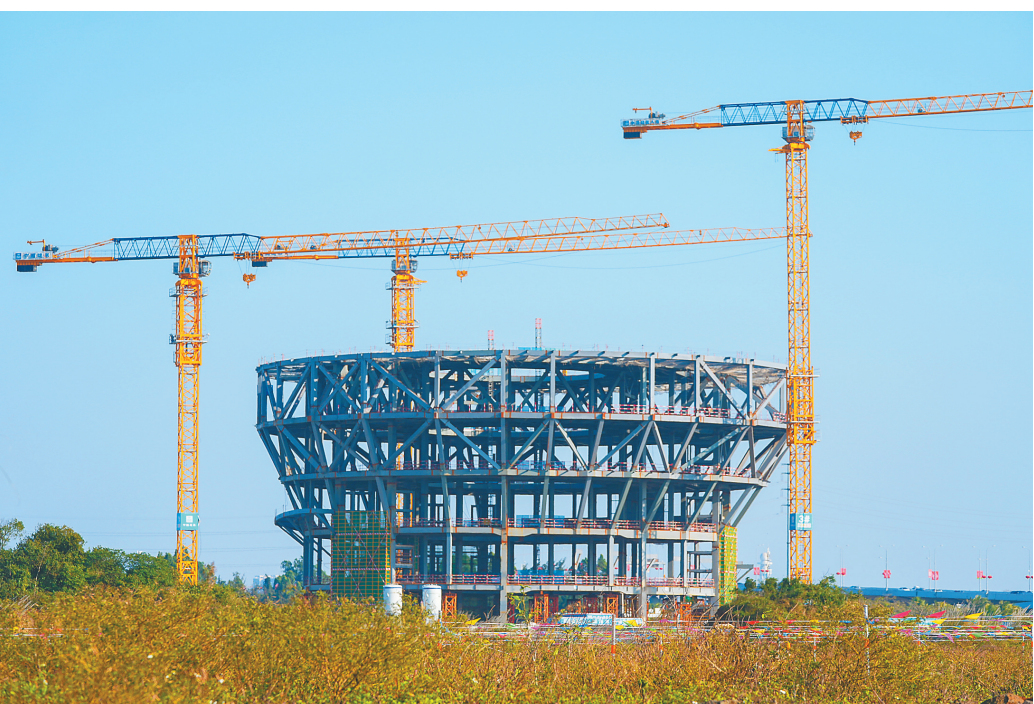
海南科技馆主体钢结构封顶
