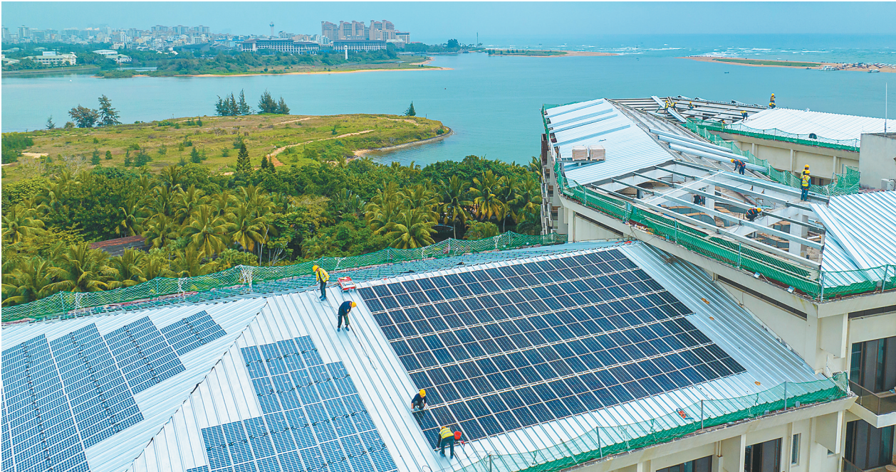
1月31日,工人在博鳌东屿岛零碳示范区项目现场铺设光伏板。
