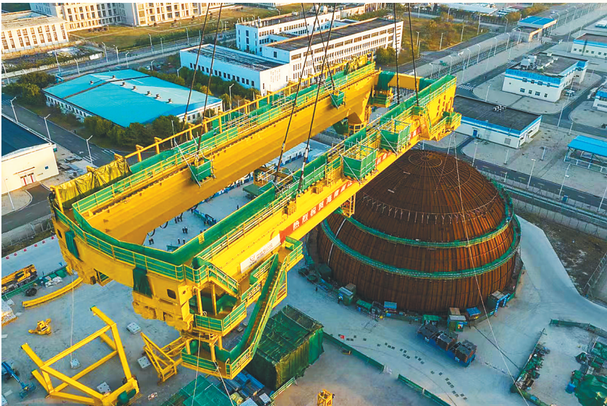
海南昌江核电厂3号机组环吊主梁整体吊装就位。(海南核电有限公司供图)
