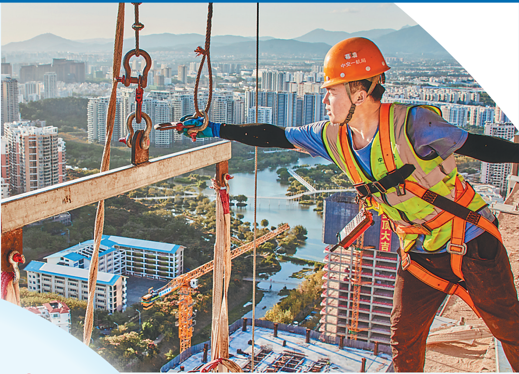
2月8日,三亚中交国际自贸中心总部项目的工人在安装幕墙。 本报记者 封烁 摄
