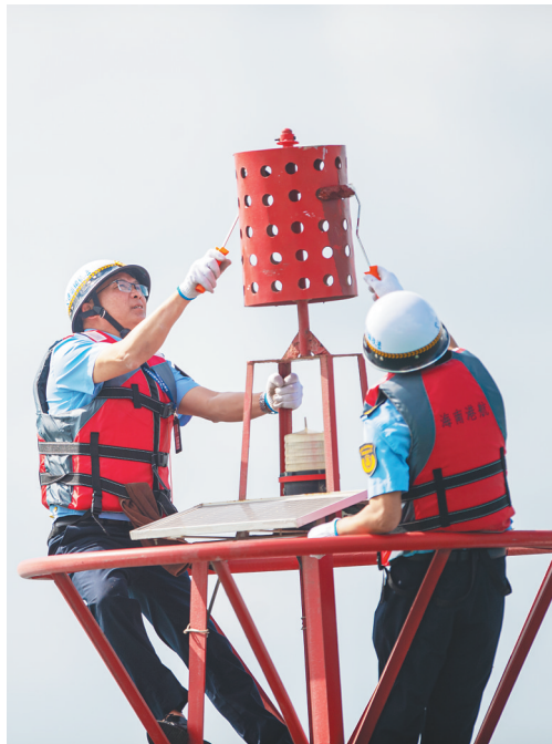
航标工对掉漆的浮标进行刷新处理。
