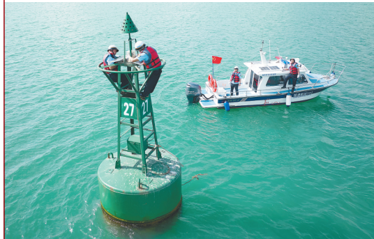
在海口港马村港区,航标工对航标进行日常维护。
